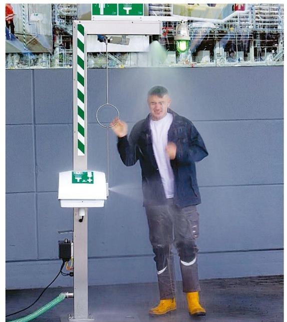
Frostsichere Notdusche mit zusätzlicher Körpersprühdüse im Einsatz
