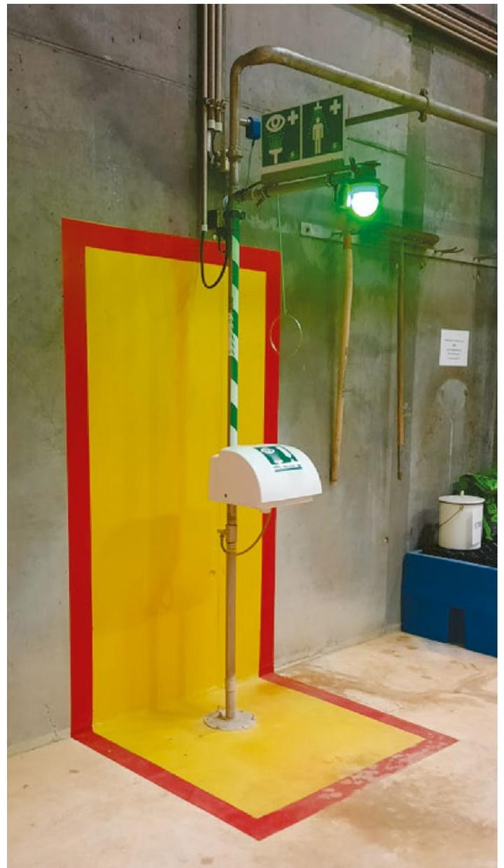
Notdusche mit Augendusche zur Innenaufstellung mit optimaler bauseitiger Kennzeichnung des Aufstellortes
