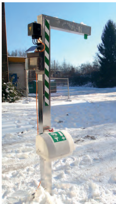
Notdusche im Winterbetrieb / Safety shower in wintertime
